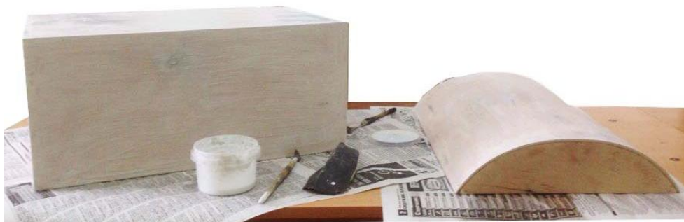
Рис. 3. – Шпатлевка и грунтовка короба и крышки
