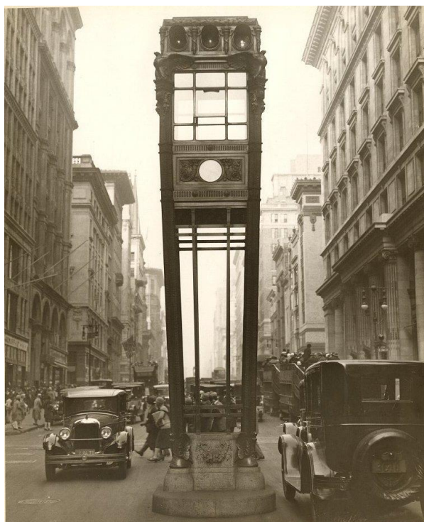
Рис. 3. Башня со светофором, установленная на 5-ой авеню в Нью-Йорке
